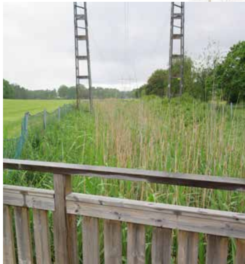
Befintlig bro över Nälsta bäck
