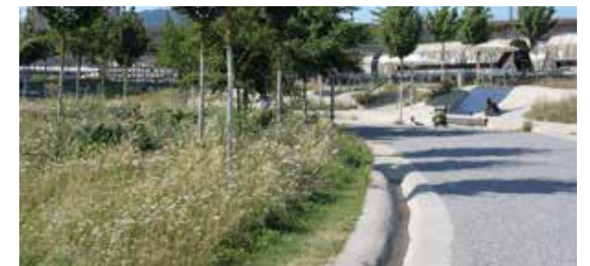
Referensbild: Ränna leder vatten till uppsamlingspunkt i Zürich, Schweiz.
